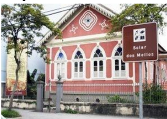
Figura 6 – Fachada Solar dos Mellos
